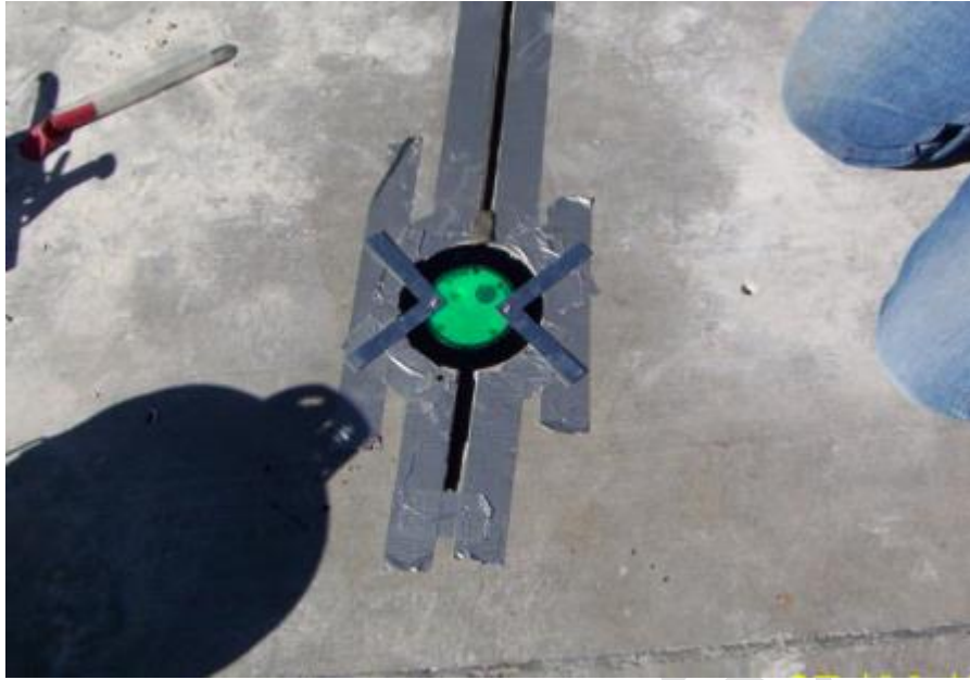
图 2-11 安装附件的应用 用树脂混凝土（环氧树脂）填充空腔，保持在 80^{\circ}\text{C} 以下硬化，否则路况传感器可能被损坏（图 2-6）。
