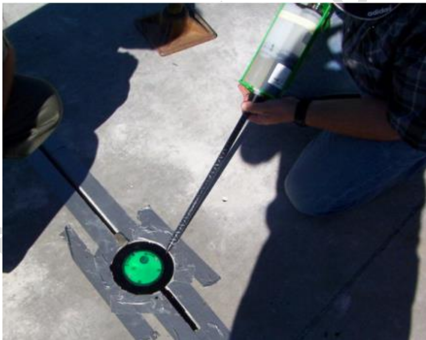
图 2-12 在设备空隙注入环氧树脂
